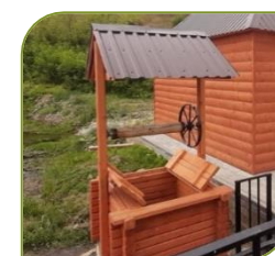
Обустройство колодцев и водоразборных колонок
