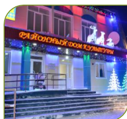
Организация освещения, подсветки зданий
