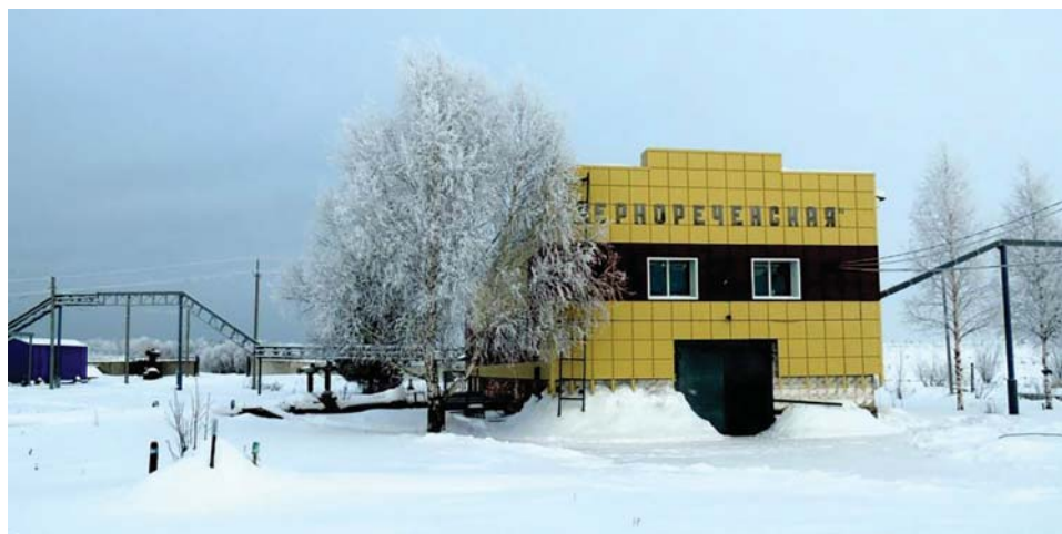
Фото 2. Насосная станция «Чернореченская»
